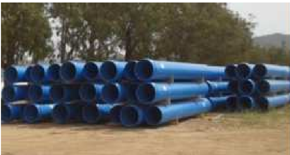
Рисунок 4 - Разгрузка с автотранспорта и складирование труб ПВХ-О класса 500
