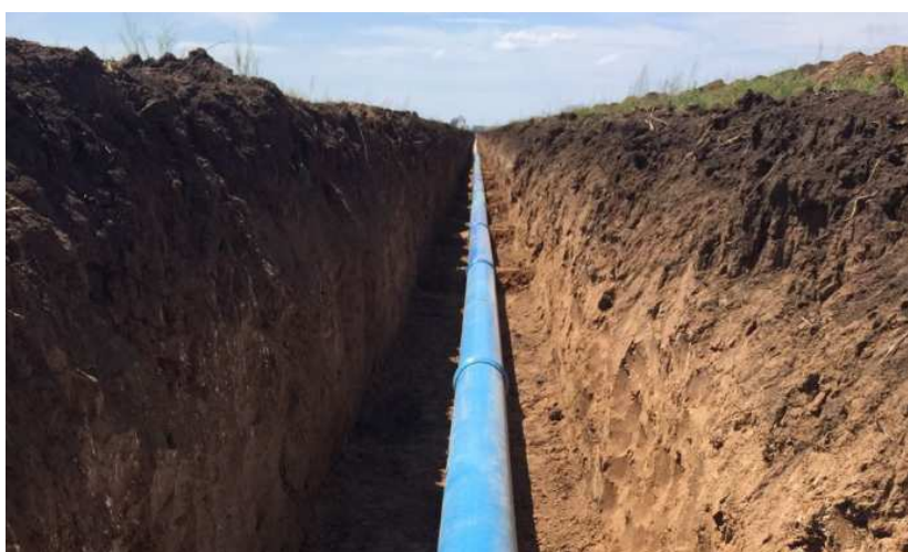
Рисунок 5 - Стыковка труб и смонтированная труба ПВХ-О в траншее
